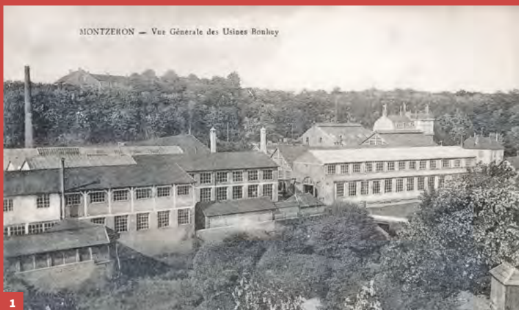
1. Montzeron (hameau de Toutry), les usines Bouhey, carte postale, vers 1910 Pothain, éd. Avallon, collection particulière
