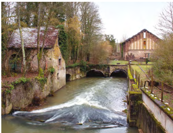
Bâtiments et aménagement subsistants des forges de Maisonneuve à Précy-sous-Thil © PAH
